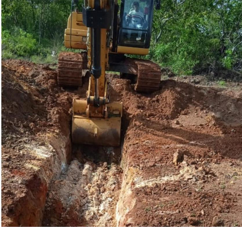
Figura 4.4 excavación de una trincheras usando maquinaria pesada. La parte en coloración blanca corresponde a la pegmatita descompuesta por el intemperismo.
