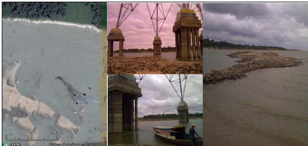
Figura 5.12 A la izquierda Imagen de satélite Landsat mostrando a la Torre T4 a 400 m de la ribera, dentro del cauce del río Orinoco para el 02/09/2015 (Google Earth, 2022). Al centro imágenes de la torre a 220 m de la ribera para el año 2008. A la derecha, restos de enrocado de los viejos gaviones de protección construidos en la ribera en el año 1992 (Huascar, C.A., 2008).
