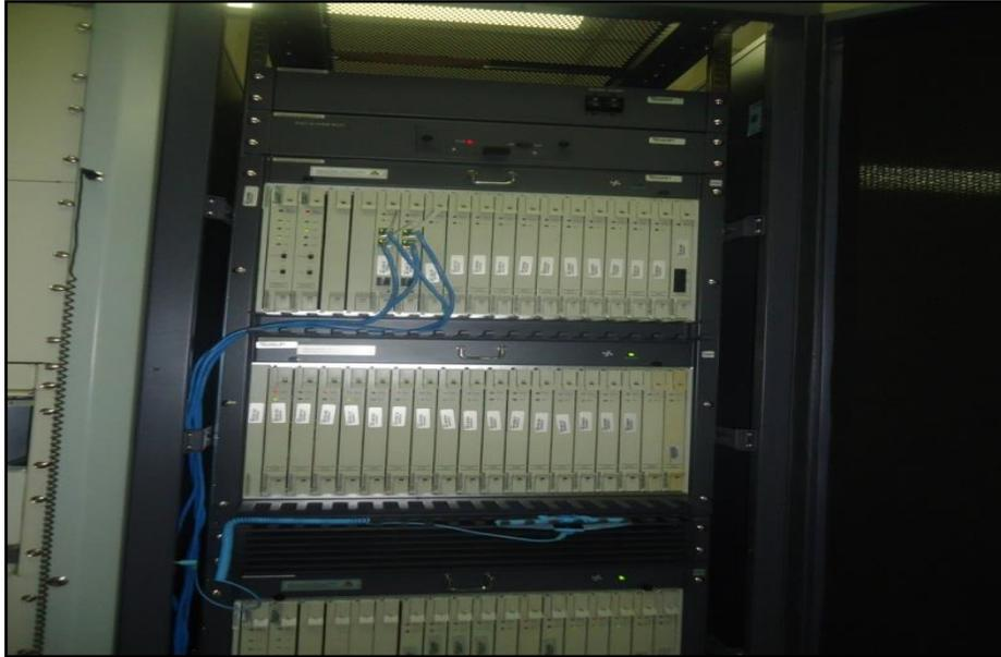
Figura 5.6 Equipo huawei indoor (voz) (Sala de conmutación, 2018)
