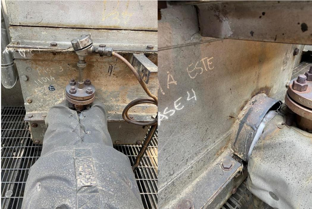
**Figura 4.5 Infiltraciones de aire en los hornos F-1101**
