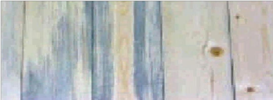
Figura 3.5. Ataque por hongos en piezas machihembradas de pino Radiata. (Fritz, 2010).
