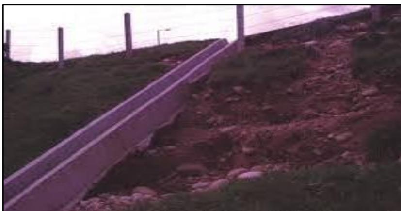
Figura 6.3 Ejemplo de torrentera socavada por las aguas de escorrentía.
