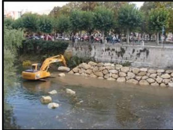
Figura 3.9 Protección de orilla con enrocado Riprap (Cardenas, 2012).
