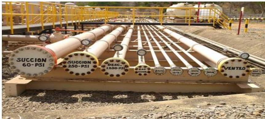
**Figura 4. 2 Cabezales de Tuberías.**
