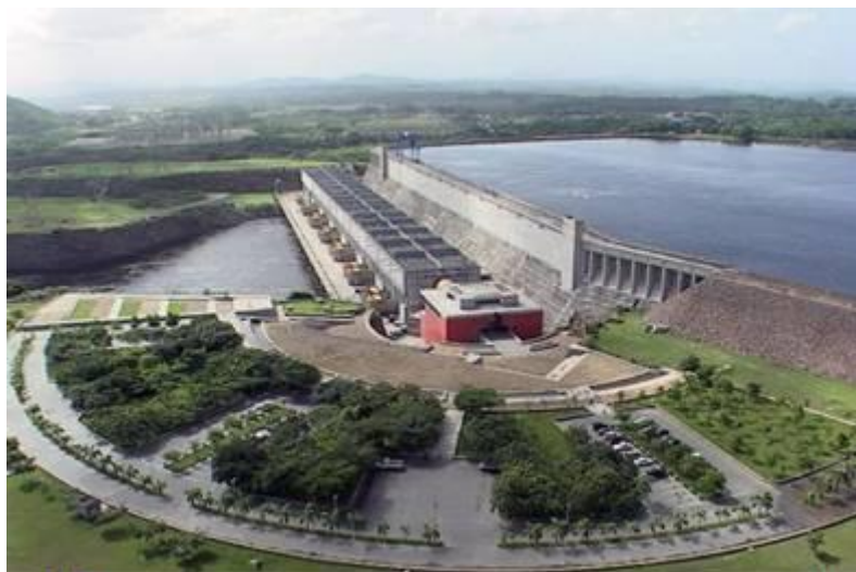
Figura 4.6 Central Hidroeléctrica Antonio José de Sucre - Estado Bolívar Fuente: www.edifica.com
