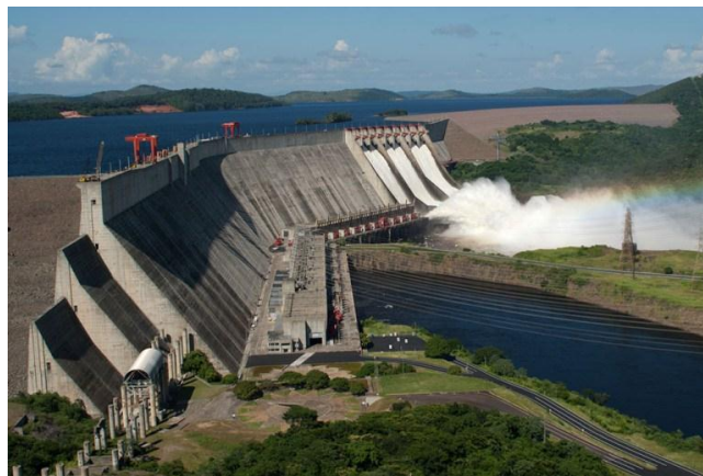
Figura 4.5 Planta Hidroeléctrica Simón Bolívar “El Guri”- Estado Bolívar Fuente: www.corpoelec.gob.ve
