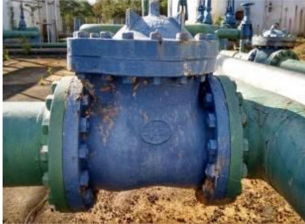
**Figura 2.2 Válvula antirretorno de la planta potabilizadora de la estación Santa Rosa**
