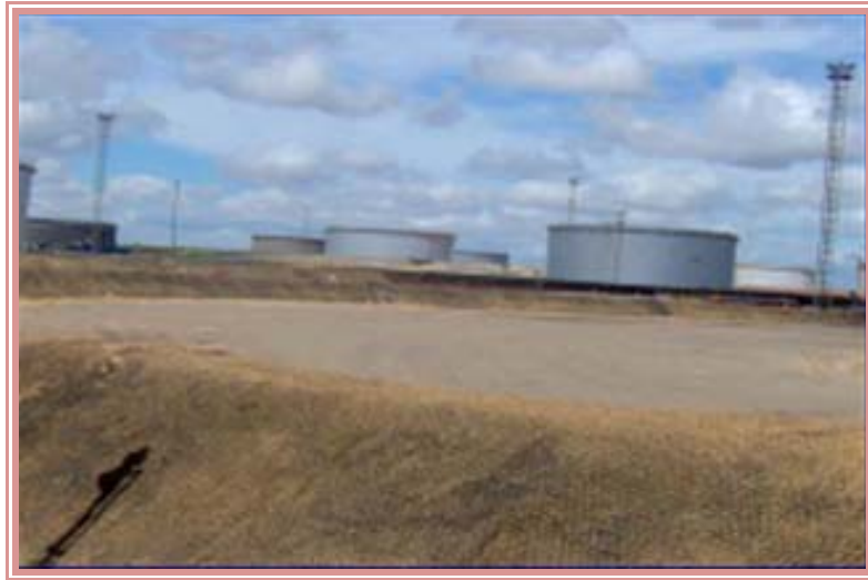
Figura 2.6. Tanques de almacenamiento de la Segregación Merey [7]
