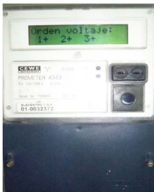
Figura 4.1. Contador CEWE Prometer 4343.
