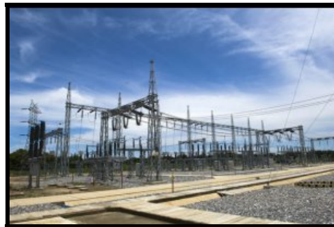
Figura 1.1.D.- Línea de Transmisión Calabozo – San Fernando
