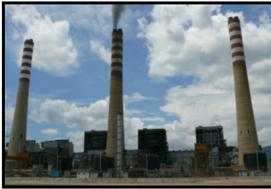
Figura 1.1.G.- Modernización y Rehabilitación Planta Centro I
