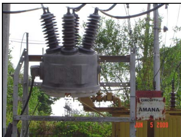
Figura 3.28. Reconector Tipo GVR de la Salida del circuito Amana [El Autor]
