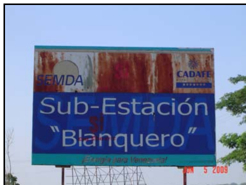
Figura 3.18. Entrada a la S/E El Blanquero [El Autor]
