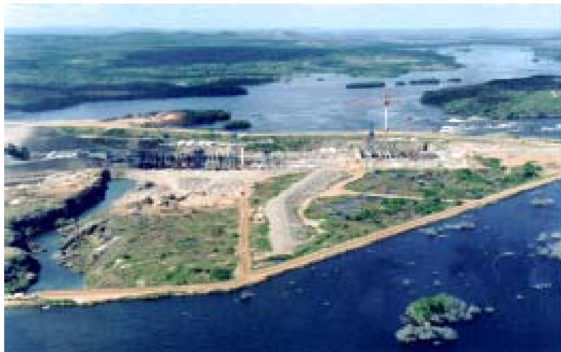
Figura 1.4. Central Hidroeléctrica Manuel Piar en Tocomá (En Construcción)
