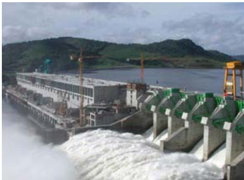
Figura 1.3. Complejo Hidroeléctrico Francisco de Miranda en Caruachi.
